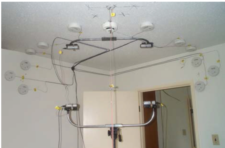
Figur 2-1 Fra et av forsøksoppsettene ved undersøkelser av effekten av "dead air space". Det ble montert røykvarslere av forskjellige typer på forskjellige steder, både innenfor og utenfor den sonen som er påkrevet i Nord-Amerika. Foto: [20].
