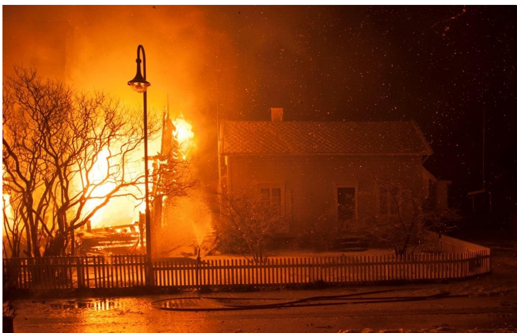
Figur 8-9 Bygget til venstre er Øyragata 68 som står i brann. Til høyre er Øyragata 66 som er dekket av skum. I tillegg benyttes vannslange til å kjøle branngasser og fasade nærmest Øyragata 68. Øyragata 66 ble reddet som følge av innsatsen. Foto: Elias Dahlen/ Bergens Tidende.
