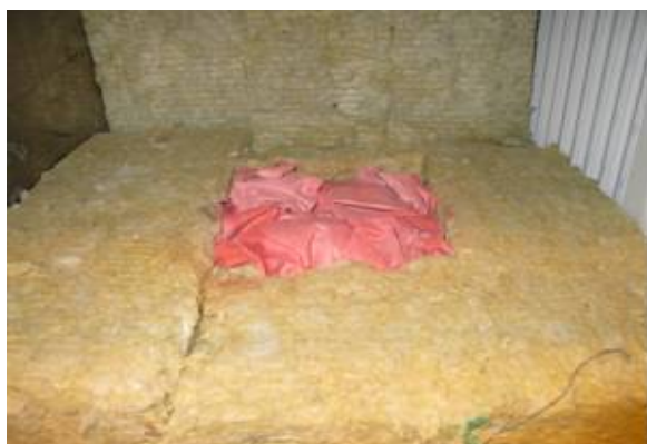
a) 3 x 1 m 2 bomullsfiller dynket med 300 ml treolje ble plassert i hulrommet.
