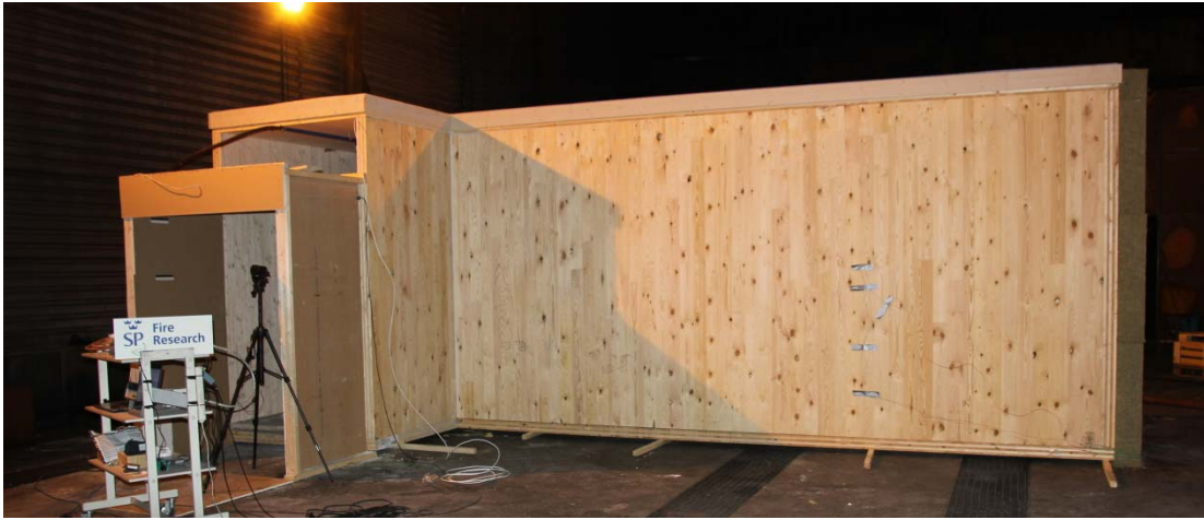
Figur A. 1 Oversikt over hybel og korridor fra utsiden tatt mot den beskyttede veggen (massivtre kledd med isolasjon og gips på innsiden).
