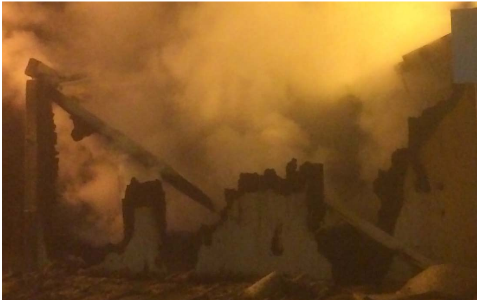
Figur 4.9 Restene av den ubeskyttede veggen etter at gipsveggen på utsiden datt ned.
