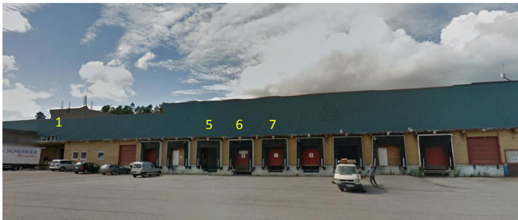
Figur 2-2 Plassering av portene på fremsiden av bygget. Portene som er omtalt er angitt med gule numre. Bildet er hentet fra Google Earth.
