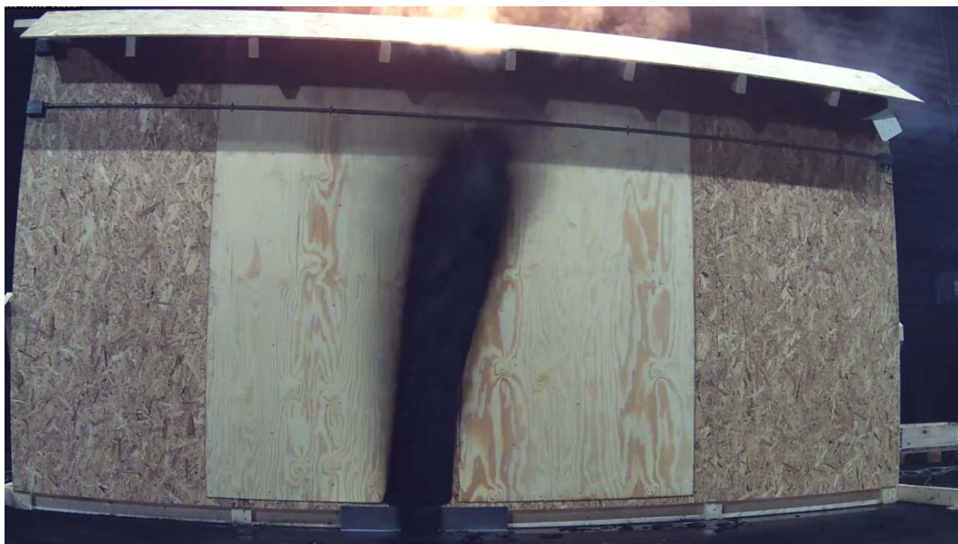
Figur 4-4 Skadene på veggen rett etter brannen ble slokket, 8 minutter og 44 sekunder etter brannstart.
