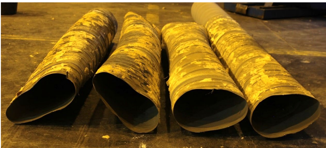
Figur 4-19 Kanalen er saget opp ved opphengspunktene for å vise deformasjonene i disse punktene. Kanaltverrsnittene har befunnet seg i 1,5 m, 3,0 m, og 4,5 m avstand fra ovnen (fra venstre mot høyre). Kanalens tverrsnitt ble redusert med ca. 25 % på grunn av deformasjonen. Bildet er fra test R4.
