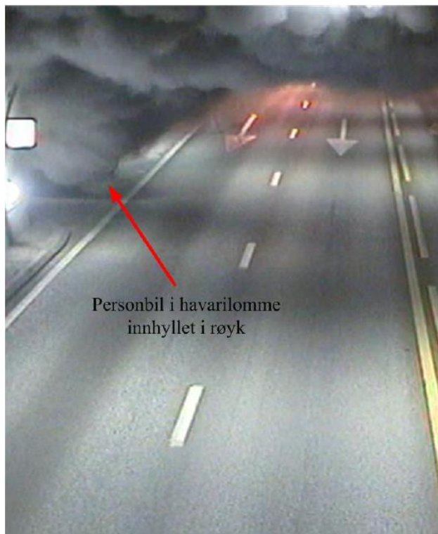
Figur 3-22 Bilde fra brannen i Oslofjordtunnelen i 2017, for å illustrere hvordan røyksjiktning i veitunnel kan se ut, før hele tunnelens tverrsnitt fylles med røyk. Bildet er hentet fra [31].
