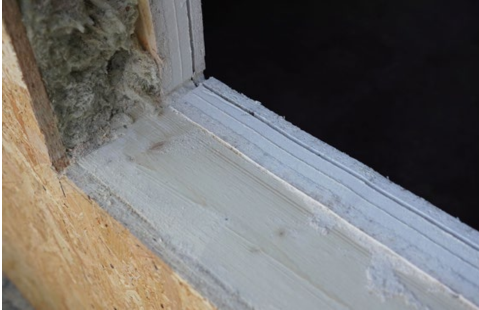
Figur A - 2 Oppbygging av vegg. Bildet tatt fra utsiden av brannrommet ved ventilasjonsåpningen.
