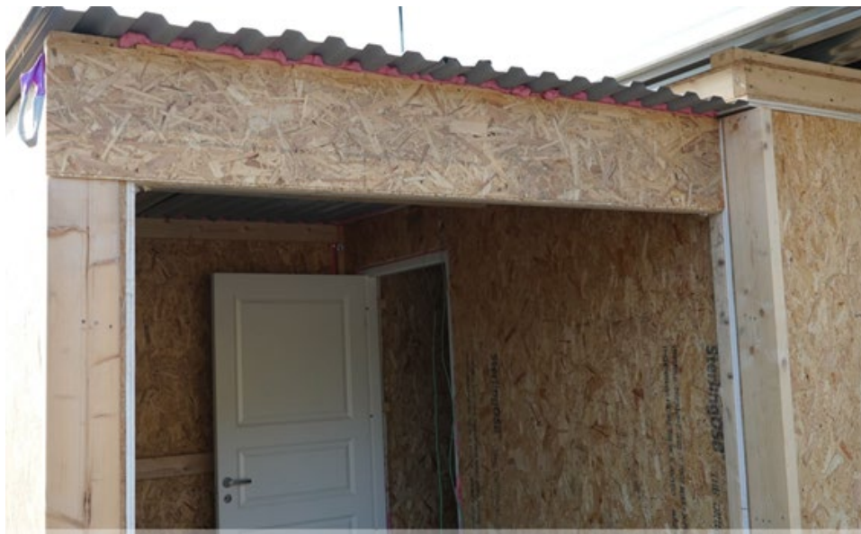
Figur A - 3 Testtrigg sett fra utsiden. Bildet viser korridor og døråpning inn til brannrommet. Oppbyggingen av taket er synlig øverst til høyre i bildet.
