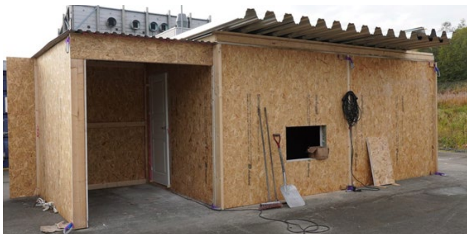
Figur A - 4 Brannrommet med korridor sett utenfra. Ventilasjonsåpning vises midt i bildet, her uten luke.
